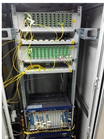
Fot. 5 Węzeł Konin – rozszycie światłowodu na ODF
