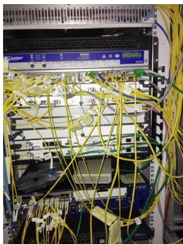
Fot. 2 CZS Poznań – urządzenia aktywne DWDM
